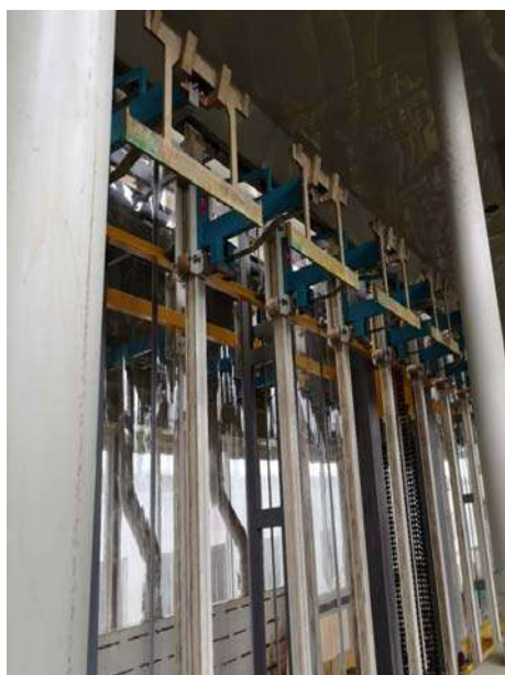
环形线软帘封闭措施
